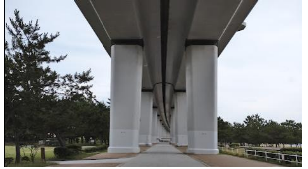
湾岸線の橋桁
